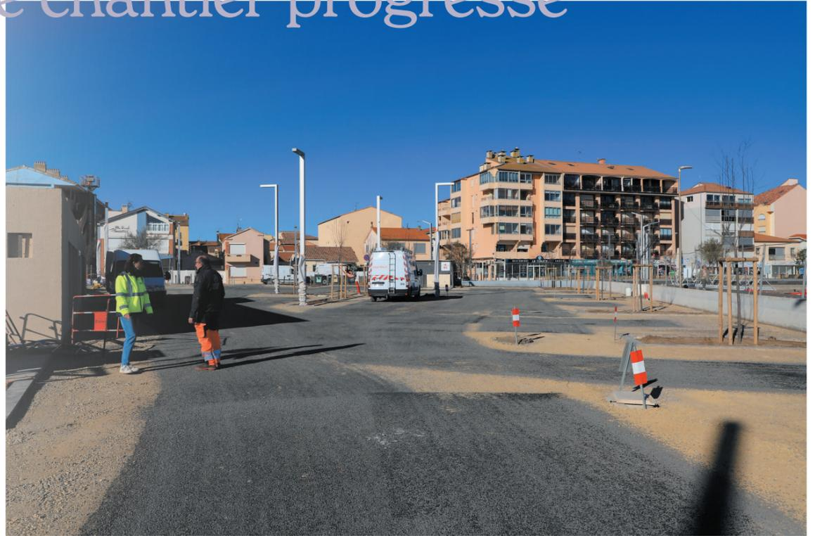
Les travaux de l'esplanade Turco avancent à bon rythme. Le revêtement de la place, mêlant harmonieusement galets sciés, dalles en pierre et béton rose, est en cours de finition.
